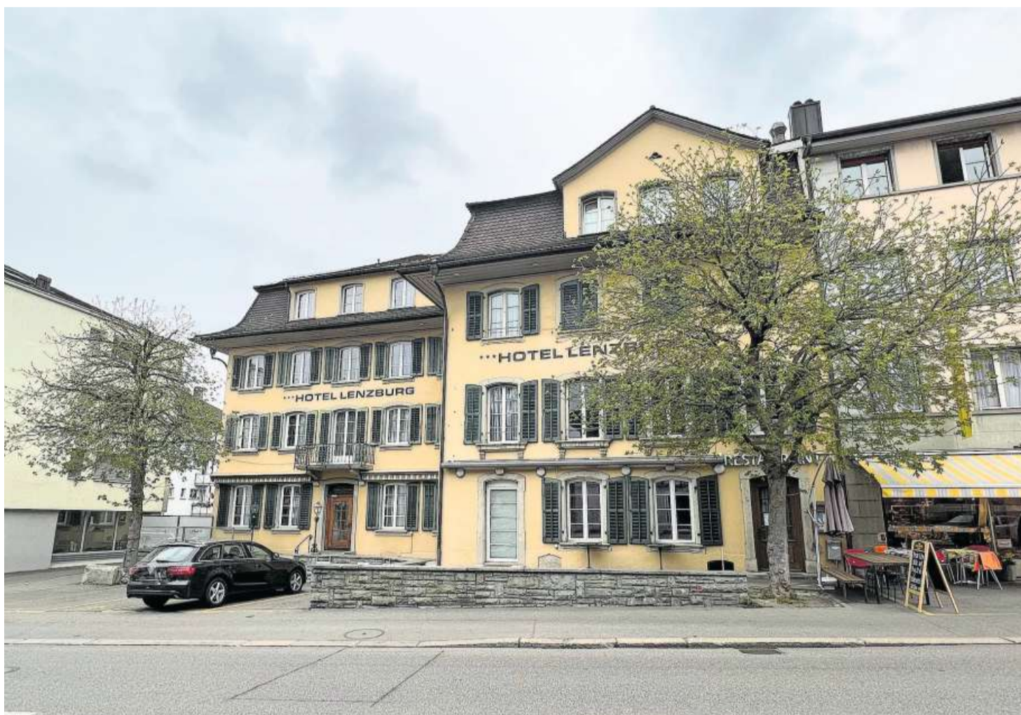
Das ehemalige Hotel Lenzburg wurde wegen der Pandemie geschlossen und steht seit über einem Jahr leer.
