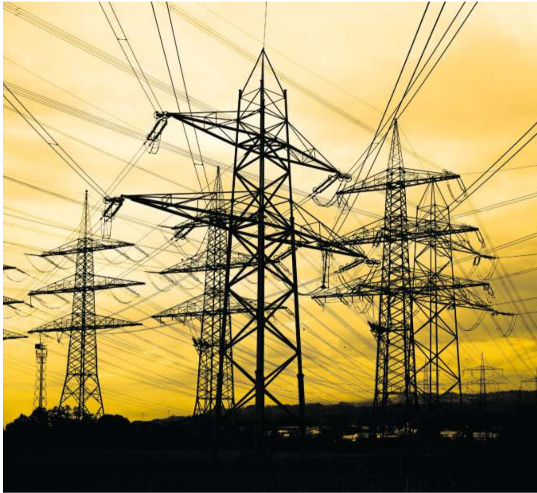
Strom kostet nächstes Jahr im Aargau – hier ein Unterwerk beim ehemaligen Swissgrid-Areal in Laufenburg – empfindlich mehr, im Schnitt fast 35 Prozent. Bild: Stefan Bohrer/Keystone
